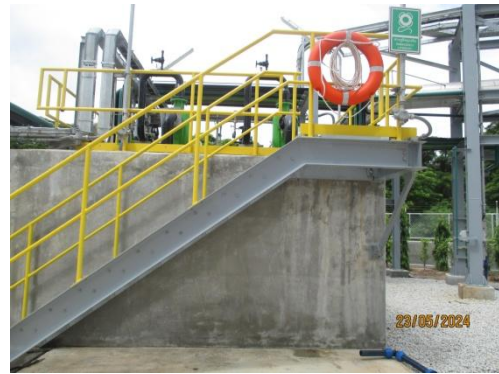
รูปที่ 3-7 ถังตรวจสอบสภาพน้ำเสีย
