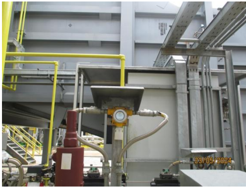
รูปที่ 3-39 Gas Detector
