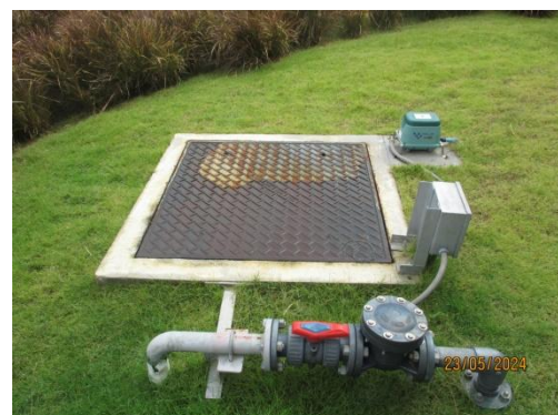
รูปที่ 3-5 ระบบบำบัดน้ำเสียสำเร็จรูป บริเวณอาคารสำนักงาน
