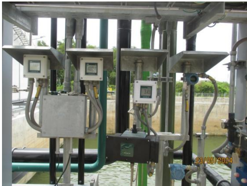
รูปที่ 3-8 เครื่องตรวจวัดคุณภาพน้ำทิ้ง แบบอัตโนมัติ
