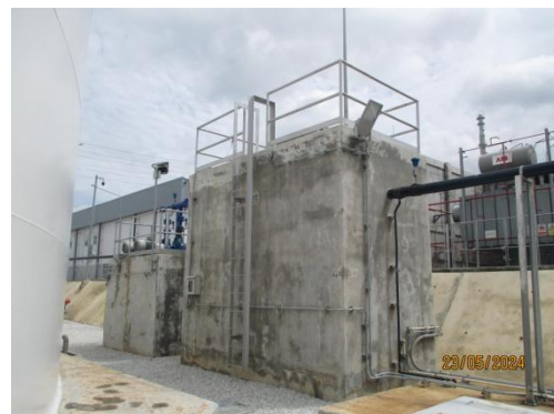
รูปที่ 3-11 ถังดักน้ำมันบริเวณลานไถไฟฟ้า
