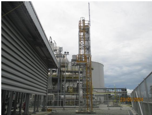
รูปที่ 3-47 ปล่องระบายก๊าซ (Blow Down Stack)
