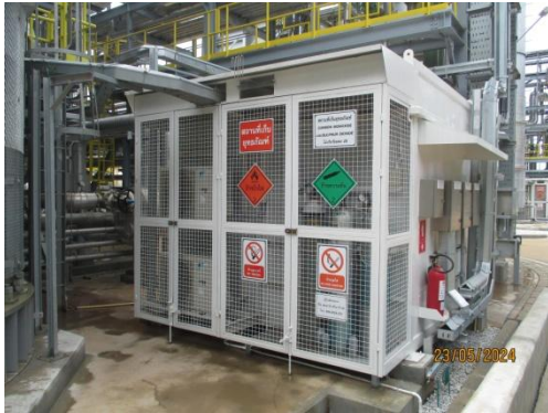
รูปที่ 3-1 ระบบการติดตามตรวจสอบ คุณภาพอากาศแบบต่อเนื่อง (CEMS)
